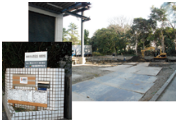
大田区城南島2-22-17の工事現場。奥の土地を掘り下げて地盤強化作業が行われている。事業開始は今年7、8月の予定。
